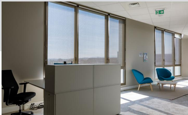
**Grâce à sa face métallisée orientée côté vitrage**, le tissu Screen Nature Ultimetal® combine, techniquement, une **forte réflexion solaire (74 %)**, une **faible émissivité de 10 %** ainsi qu'une **excellente transmission visible (Tv = 6 %)**, et ce **quel que soit le coloris**.
